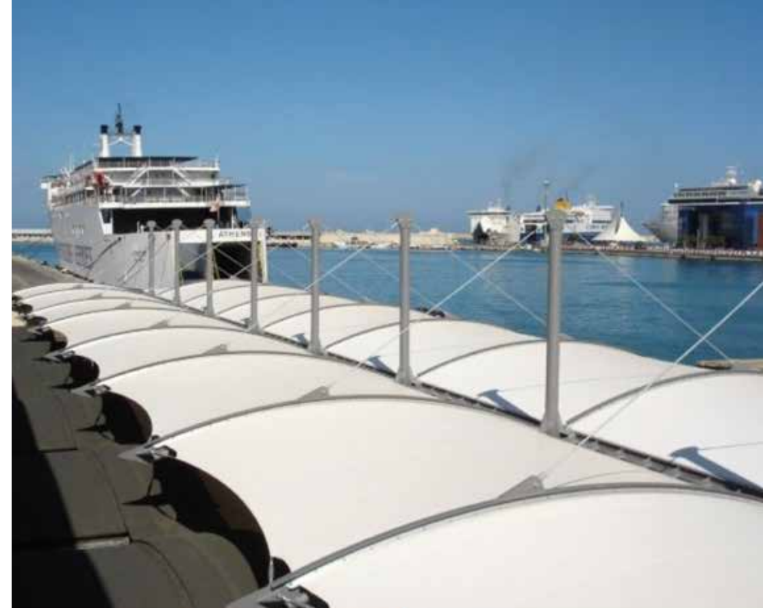
Porto di Bari, Pensiline del molo / Port of Bari, Pier shelters Gerry.D'Anza, Loredana Di Benedetto whit Baku Group, 2005. Photo by Loredana Di Benedetto).
